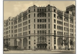
旧肥後橋本社ビル (設計:W・M・ヴォーリス)
